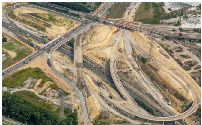
**Bild 9** Wattenscheider Straße, Luftbild 2014: Altes Bauwerk abgerissen, neues Bauwerk unter Verkehr
