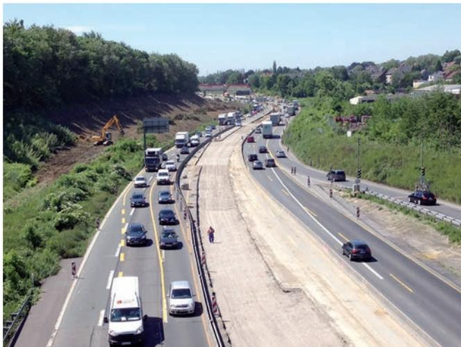
**Bild 3** 2+2-Führung und Ausbau des Mittelstreifens
