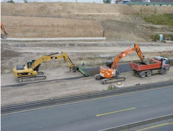
**Bild 21** Einbau des Geogitters
