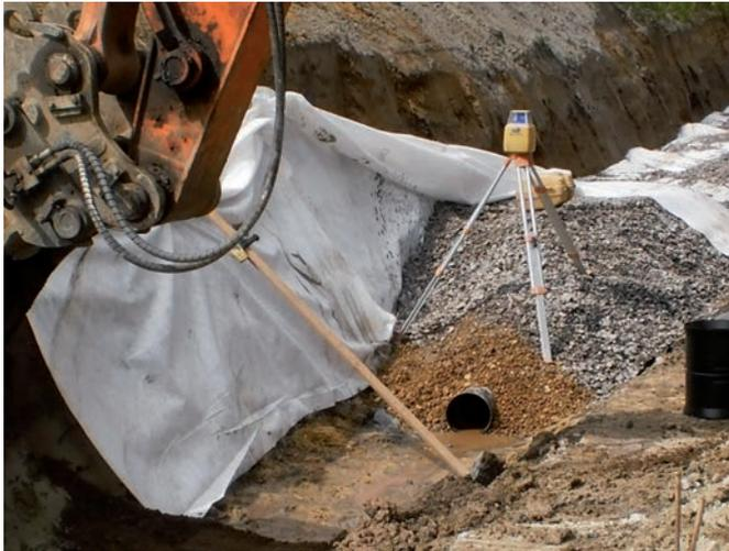
**Bild 19** Einbau der Dränage
