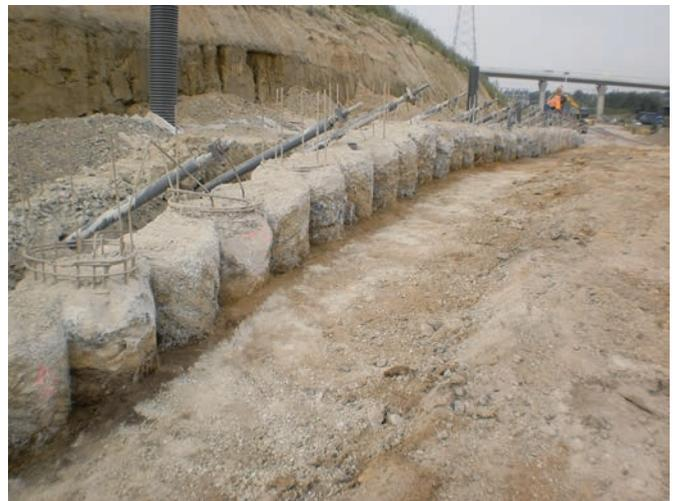
**Bild 15** Bohrpfähle und Mikropfähle der Stützwand 08
