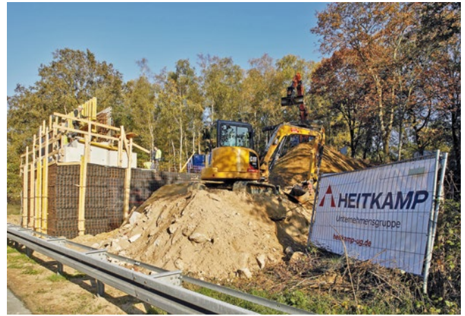
Bild 8 Herstellung der bewehrten Erde hinter dem Widerlagerbalken Production of reinforced earth behind the abutment beam
