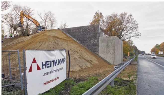
Bild 3 Verkleidung der bewehrten Erde durch Stahlbeton-Fertigteile und Gabionen Cladding of reinforced earth by precast reinforced concrete elements and gabions
