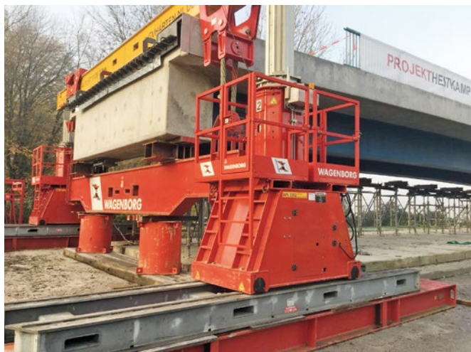
Bild 9 Anheben des Überbaus auf Endhöhe mittels Hubgerüst Lifting the superstructure to final height by means of a lifting scaffold
