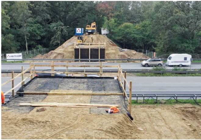
Bild 7 Teilfertiggestellte Widerlager Partly completed abutments
