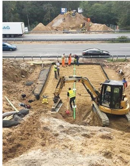
Bild 6 Parallele Herstellung der beiden Widerlager ohne Verkehrseinschränkung Parallel construction of the two abutments without traffic restrictions
