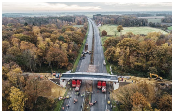
Bild 11 Brückenüberbau beim Einheben Bridge superstructure during lifting
