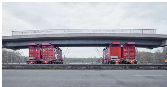
Bild 10 Brückenüberbau während des Transports Bridge superstructure during transport
