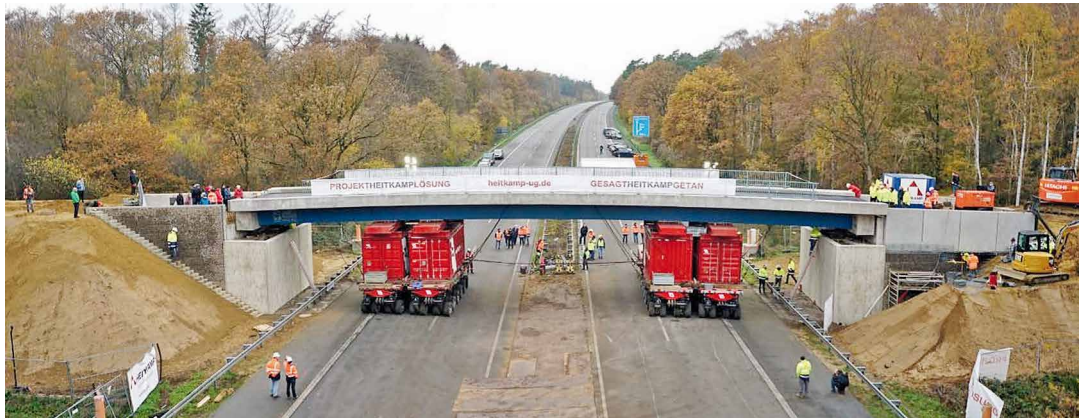
Bild 14 Einheben des Überbaus Lifting the bridge superstructure
