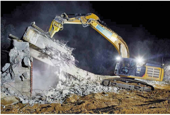
Bild 2 Abbruch des Bestandsbauwerks Demolition of the existing building
