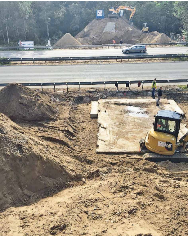
Bild 4 Freigelegtes Bestandsfundament mit Konsolbändern Existing foundation with widenings
