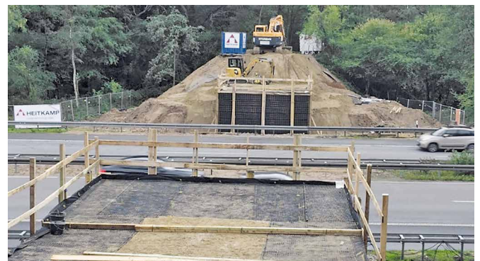
Bild 16 Aufbau des KBE-Brückenwiderlagers ohne Eingriff in den fließenden Verkehr auf der Autobahn Construction of the KBE bridge abutment without interfering with the flow of traffic on the highway
