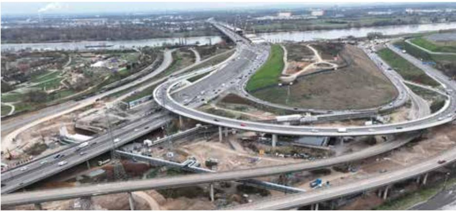
Die Verbreiterung der A1 an die neue Rheinbrücke Leverkusen baute HEITKAMP innerhalb der Altablagerung Dhünnaue
