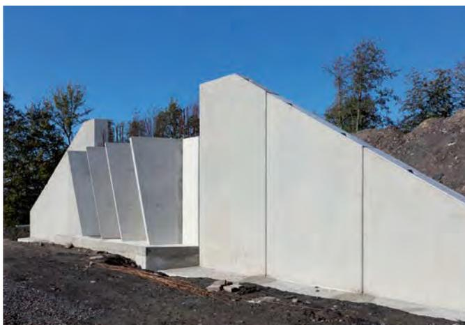
**Bild 2** Fertiggestelltes Widerlager mit seitlichen Stützwandelementen vor Auflegen des Überbaus
