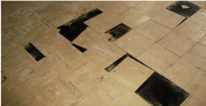
*Vinyl-Asbestbodenplatten (sogenannte Flexplatten) auf asbesthaltigem Bitumenkleber*
