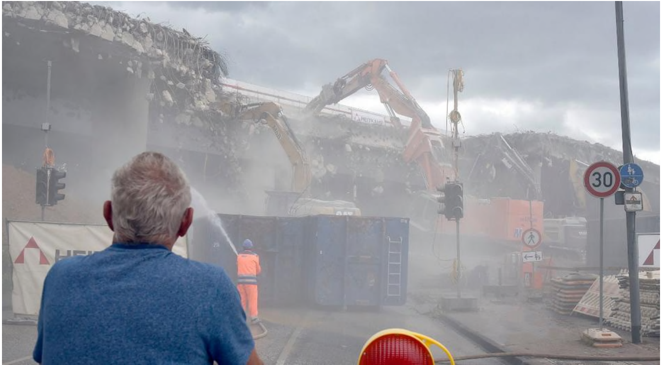
Viel Staub wurde beim Abriss der Brücke aufgewirbelt. Foto: Fries, Stefan (fri)
